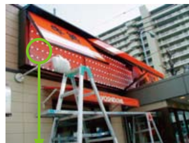
▲設置工事の様子
