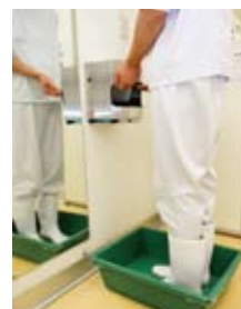
手洗い・除菌をしなければ入口のドアが開かない仕組み
